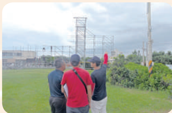
▲ 圖四：監視器小組人員與廠商討論球形攝影機架設位置
